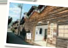
のこぎり屋根が 印象的な外観
